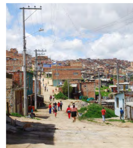
Dans certaines banlieues de Bogotá, l'infrastructure urbaine est quasiment inexistante.
